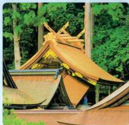
御本殿直後替葺き
