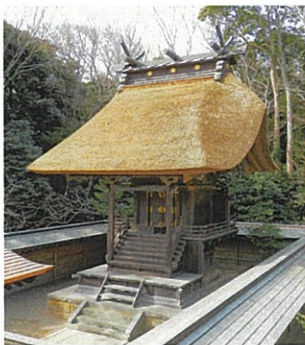
葺き替え後の御本殿
